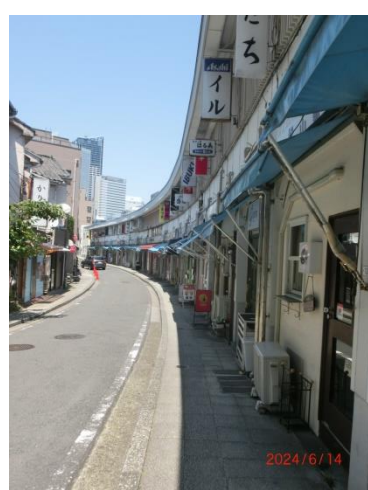
湾曲している都橋商店街ビル
