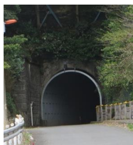
走水水道トンネル
